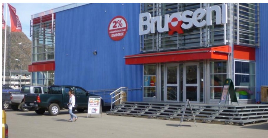
Figur 11. Hævet rampe og trappekonstruktion uden terrænhævning foran indgange. Konstruktion i gitterriste som mindsker ophobning af sne på adgangsarealerne. Sisimiut, Grønland.
