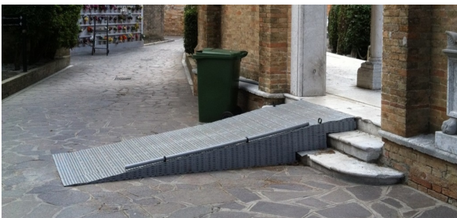
Figur 32. Hyppigt anvendt tilpasning af indgangspartier i eksisterende boliger, hvor der ikke er niveaufri adgang, både indendørs og udendørs. Et dansk system af plastelementer klippes sammen til den ønskede højde og hældning, og huller i elementerne bortleder vand eller bruges til at montere kontrastfarvede eller skridhæmmende knopper. Medfører ikke vandbelastning på soklen på en bygning. Hvorvidt opsprøjt dæmpes er ikke afprøvet. Ses også anvendt på steder, hvor man af bevaringsmæssige grunde kun ønsker midlertidige opbygninger, der kan fjernes igen. Venedig, Italien.
