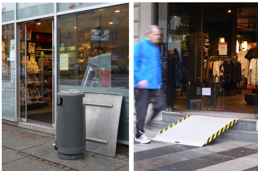
Figur 30. Løse ramper til butiksindgange, anvendes primært til udstillingsvogne og barnevogne. Anvendes som nødløsning, men har kun lille anvendelighed for personer med handicap. Løse ramper kræver oftest hjælp fra andre, og er ofte for stejle eller usikkert fastgjort. Løse ramper har dog kun få klimamæssige problemer. Aarhus.
