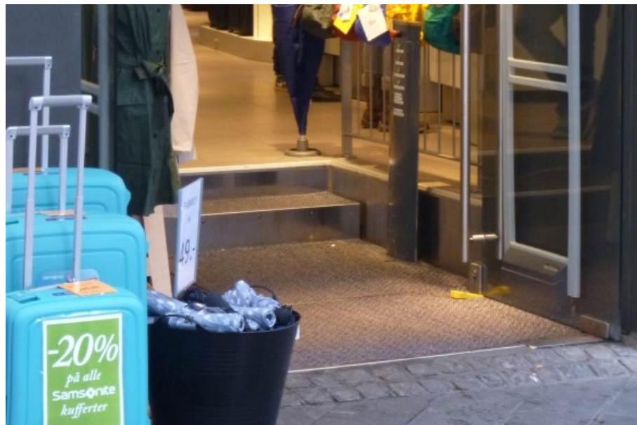
Figur 29. Løfteplatform indbygget i trappe, indendørs. Hvis de elektriske og mekaniske komponenter er godt beskyttet mod fugt, er der større sandsynlighed for, at løfteplatformen fungerer. Efter Bygningsreglementet er løfteplatforme og trappelifte ikke umiddelbart tilladte til at skabe niveaufri adgang, bl.a. fordi de ikke i tilstrækkelig grad kan betjenes af brugerne, og ofte ikke fungerer. En løfteplatform kan dog være en hjælp til at lempe mulighederne for adgang, fx i eksisterende bygninger, hvis der ikke kan indpasses en rampe. Aarhus.
