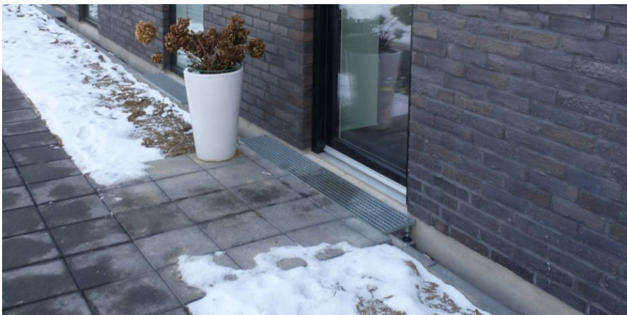
Figur 27. Nybyggeri med voldgravsløsning omkring rækkehus hvor der er sørget for fuld sokkelhøjde. Gitterriste udgør en del af reglementeret repos på 1,5 x 1,7 m. God dæmpning af opsprøjt pga. de åbne riste. Voldgraven skal forsynes med afløb. Odder.
