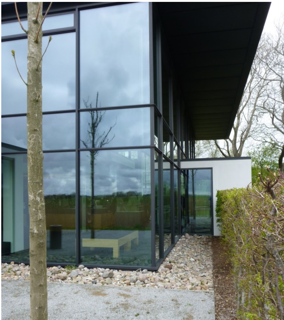
Figur 22. Bred rende fyldt med håndstore sten til dæmpning af opsprøjt. Sydslesvig, Tyskland.
