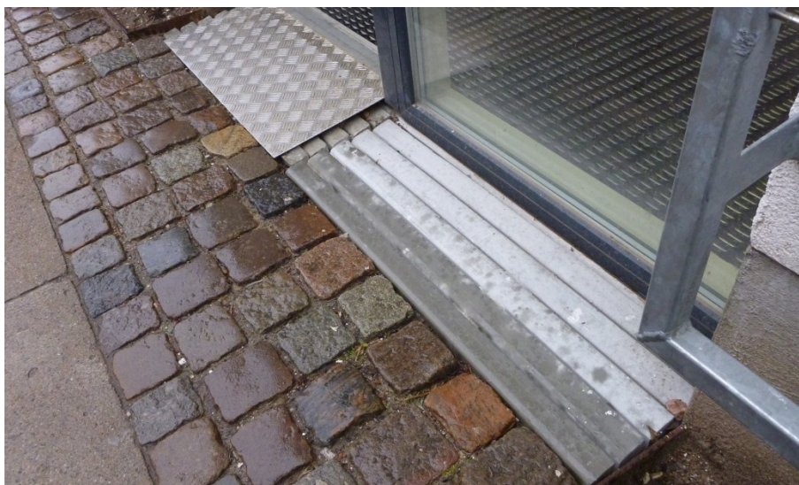
Figur 23. Rende overdækket med beton "gitter" med skrå overflader, beregnet på at mindske opsprøjt på facaden. København.
