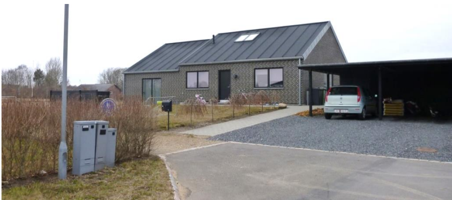
Figur 9. Fritliggende enfamiliehus på hævet terræn i lavt beliggende boligområde i marsken ved Ribe. Det hævede terræn mindsker risikoen for oversvømmelser, også ved ekstremregn.
