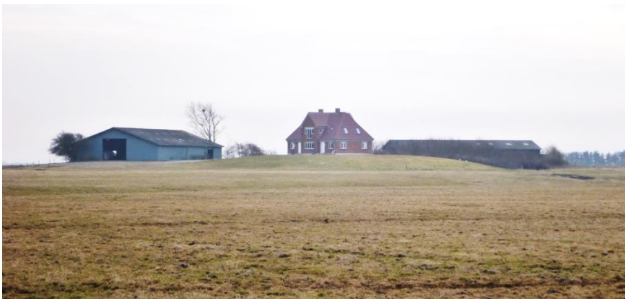
Figur 8. Bolig på varft i marsken ved Ribe. Varften er en naturlig eller kunstig bakke, som ligger flere meter over det omgivende område. Varften er en mange hundrede år gammel metode til sikring mod oversvømmelse som følge af havstigning og stormflod.
