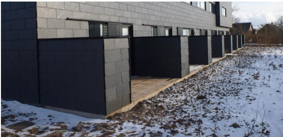
Figur 14. Træterrasse hævet over naturligt terræn, så kravet om effektiv højde til overkant af sokkel på 150 mm overholdes. Rampe til omliggende terræn er ikke påkrævet, hvis der - som her - ikke findes et egentligt adgangsareal fra vej til terrasseindgang, og det gør det lettere at anlægge tilstrækkeligt fald væk fra bygningen. Mårslet.
